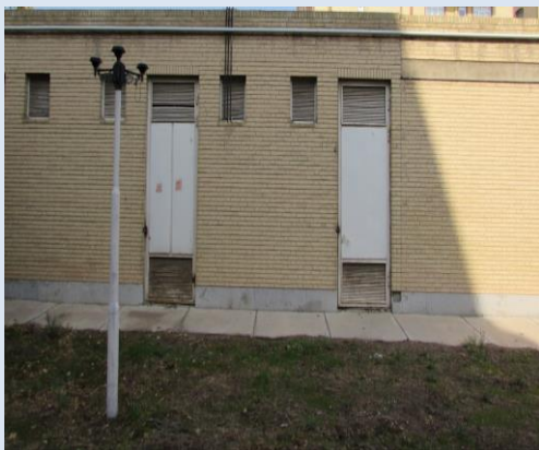
شکل ۱. مکان یابی نامناسب قسمت تاسیسات کتابخانه مرکزی تبریز- اتاق تاسیسات در مجاورت خیابان
